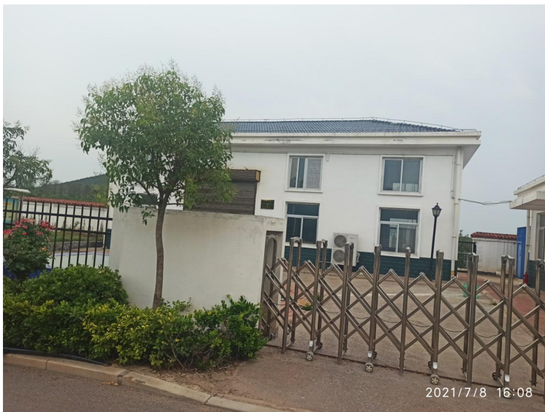
渗滤液处理厂
