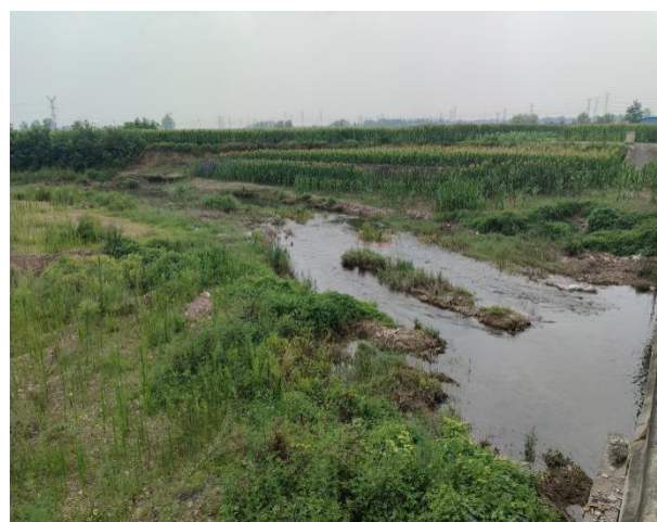
输水管线穿越河流处 1
