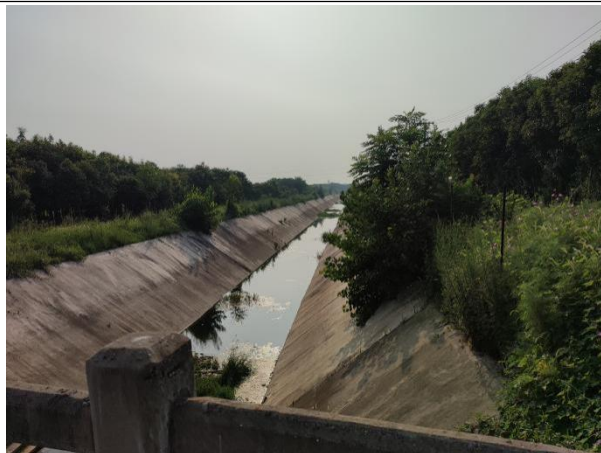
临汝镇水厂南侧陆浑东二干渠
