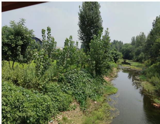
输水管线穿越河流处 2
