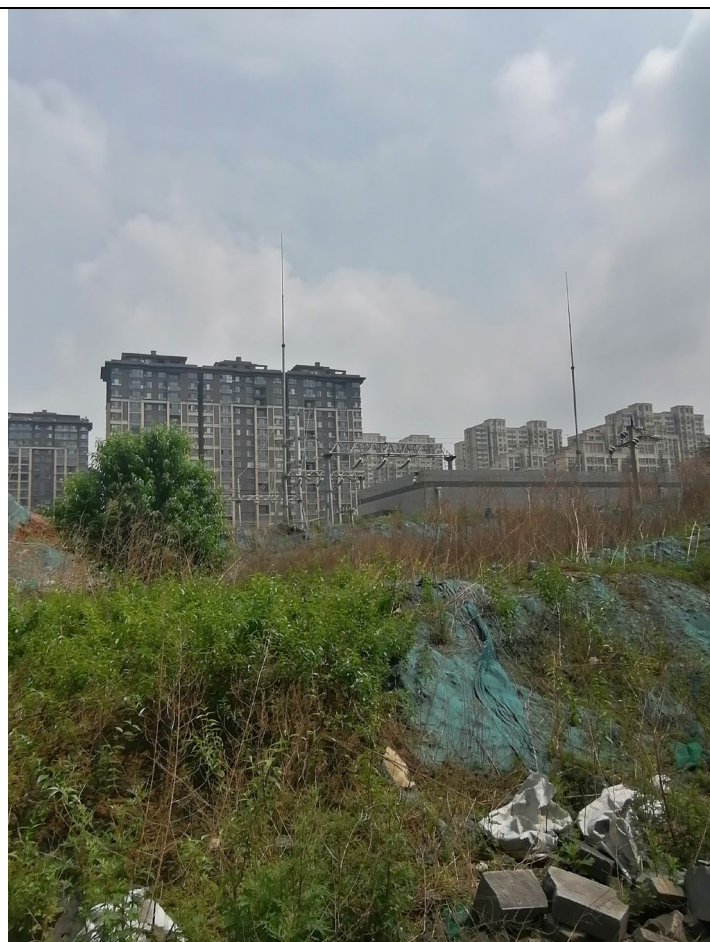
项目东北侧变电站
