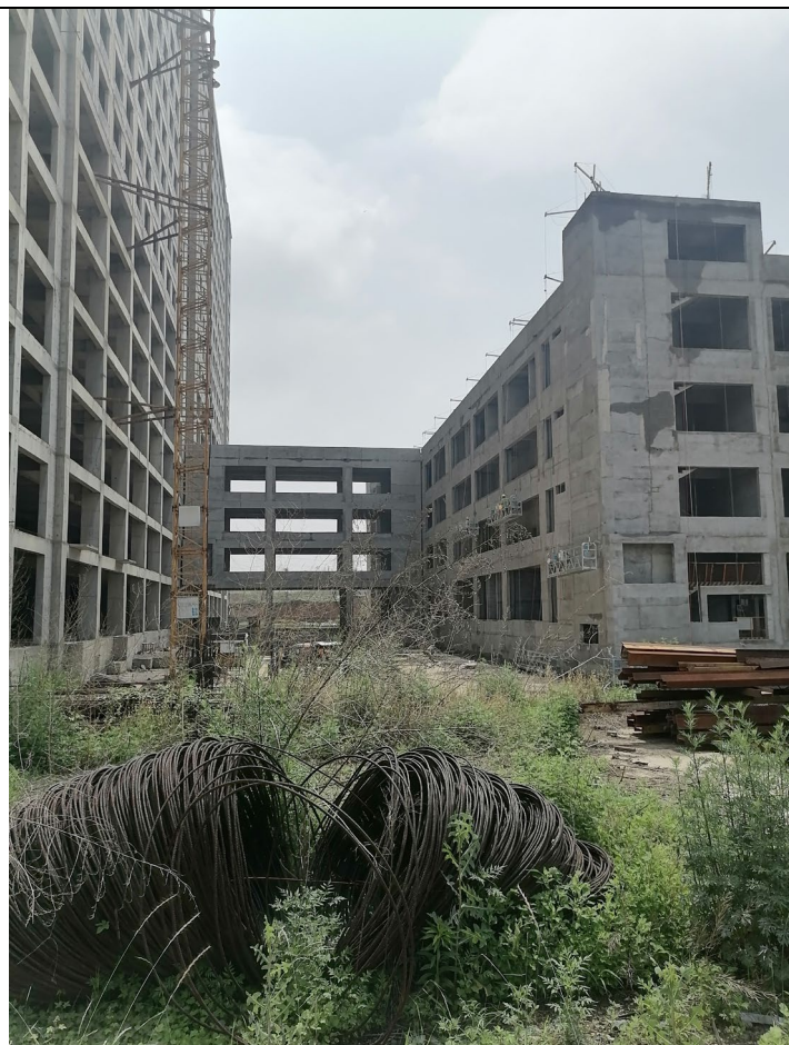
现场门诊医技楼现状
