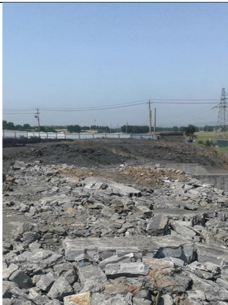
厂区内现状 现场照片
