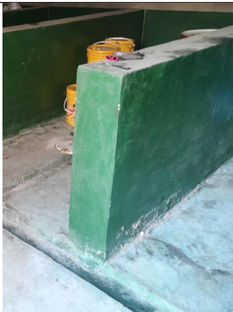
危险废物暂存间内部现状
