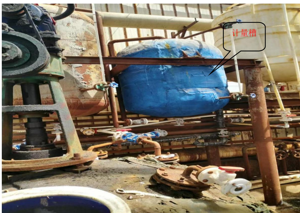
图二 物料高位槽
