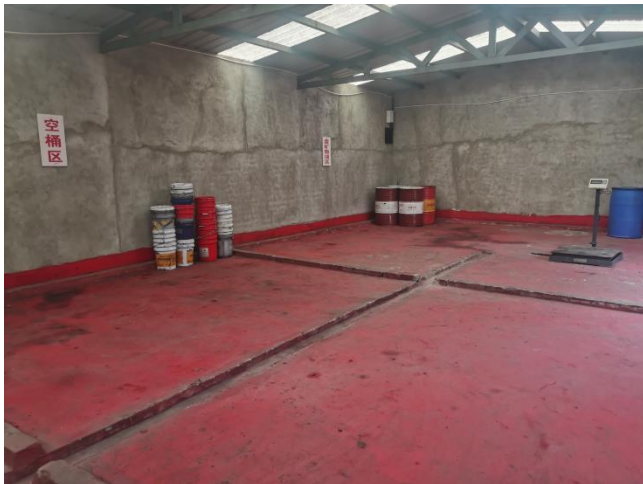
厂区危废暂存间内部
