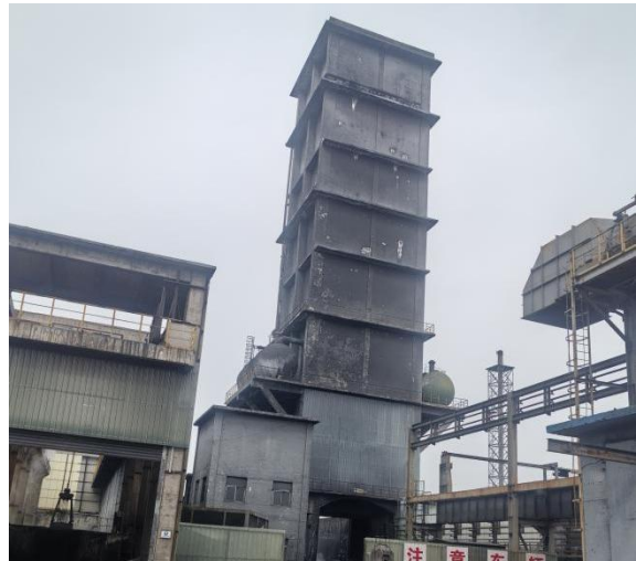
厂区现有湿熄焦装置
